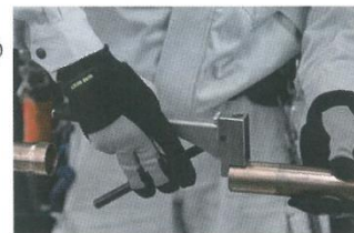
(写真 3 専用工具による窒素ガス封入口の穴あけ)
