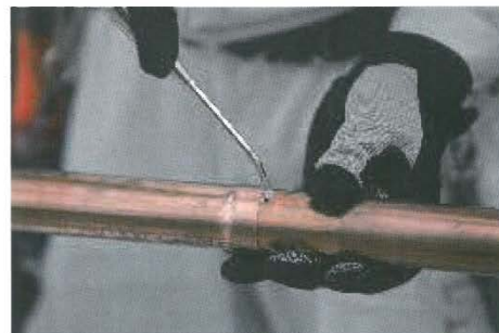
(写真 2 窒素ガス封入)
