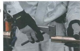
(写真 3 専用工具による窒素ガス封入口の穴あけ)
