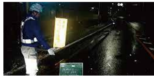
夜間土木作業
